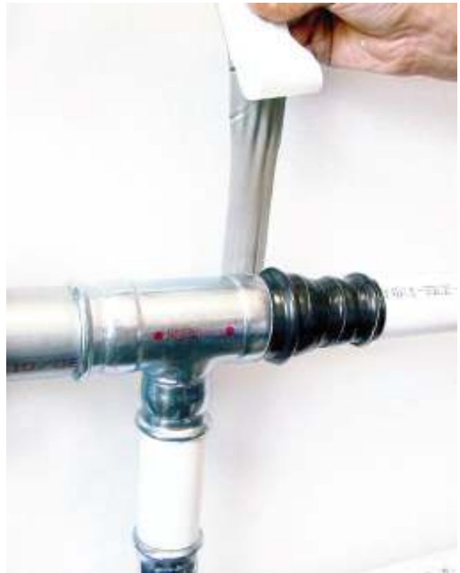
Рис. 38. Защита соединений с помощью бутаноловой клейкой ленты.
